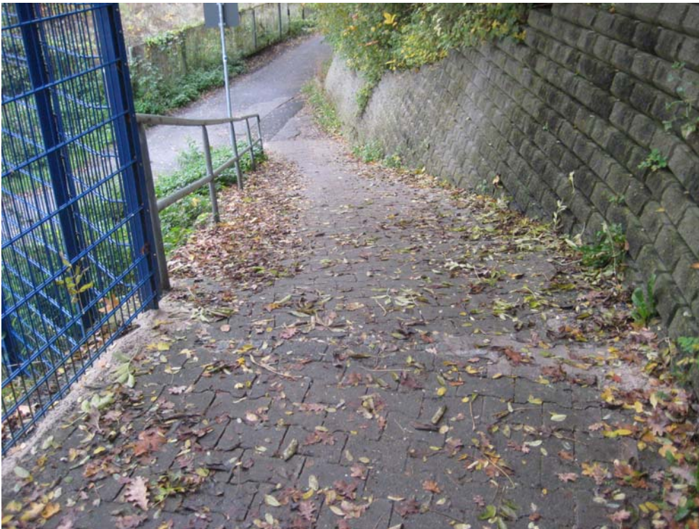
Radweg R3, kritische Rampe (verschmutzt) am Kerosinhafen
