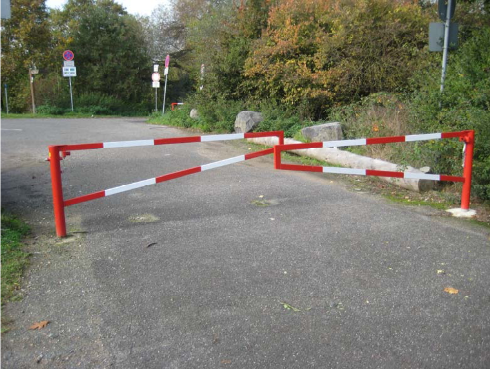
Radweg R3. Umlaufsperre in Höhe der Okrifteler Straße. (ehemals Mainfähre)
